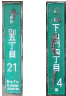
写真2 上の板がはがれた例：城南区・西区
