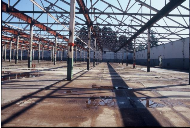
写真2 既存棟の鉄骨構造部材（屋根、外壁は撤去）
