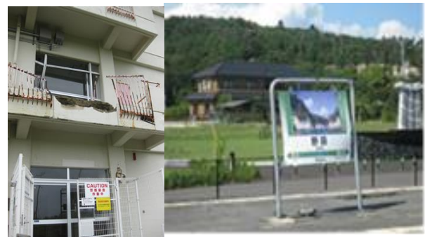
写真1(左)：震災遺構「仙台市立荒浜小学校」
